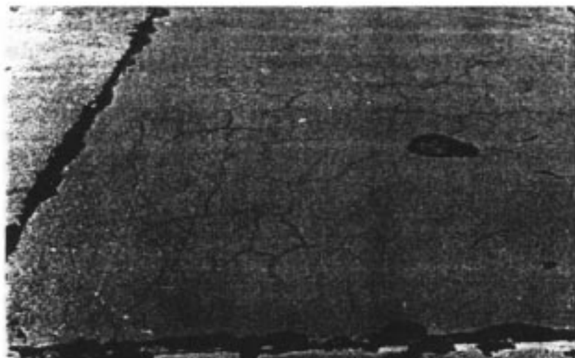
Figura 25. Microfisurarea suprafeței - nivel de gravitate scăzut
