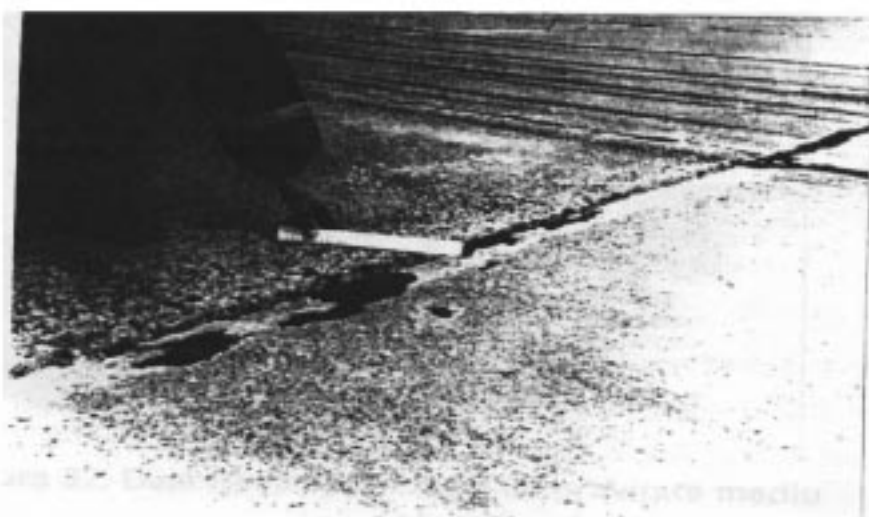
Figura 29. Tasarea diferențiată a dalelor – nivel de gravitate mediu
