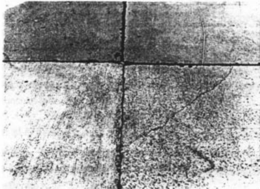
Figura 5. Fisură de colț – nivel de gravitate scăzut
