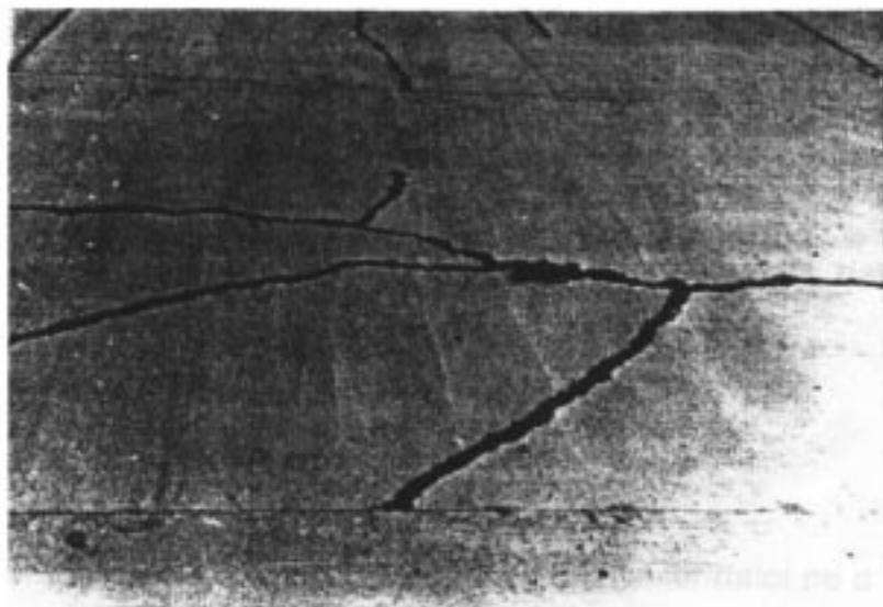
Figura 32. Dală fracturată – nivel de gravitate mediu
