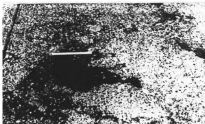
Figura 27. Exfolierea suprafeței - nivel de gravitate ridicat
