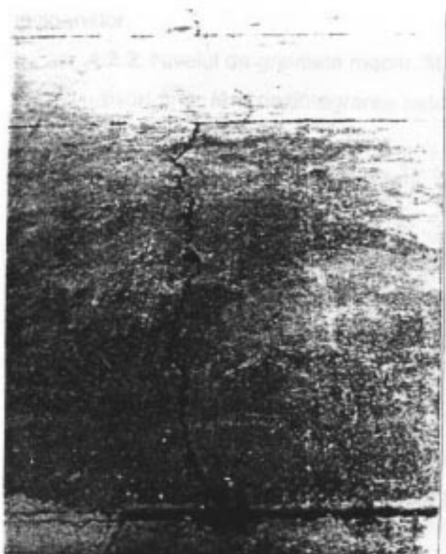
Figura 8. Fisură – nivel de gravitate scăzut
