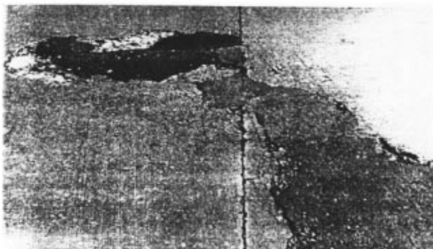
Figura 22. Plombare suprafață mare - nivel de gravitate ridicat
