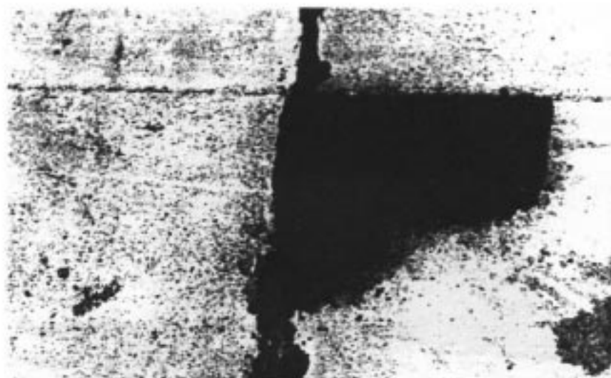
Figura 17. Plombare suprafață mică - nivel de gravitate scăzut
